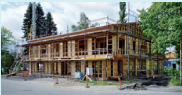
現地で当社のBF構法で建築中の学生寮
